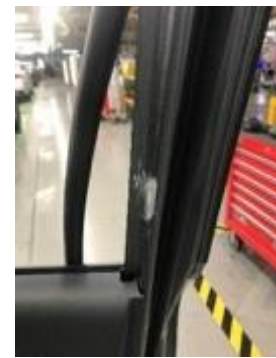
Figura 25. Reparación en PLT1 de sello embarrado en door sash.
